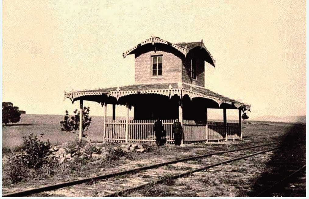
1872 yılında kurulmuş olup, yazları istasyon kışları karakol olarak kullanılan, 1900'lü yıllar başında halka geniş çapta hizmet verdiği bilinip, 1.Dünya Savaşında Anadolu'ya silah ve malzeme sevkiyatı yapılmasına aracı olan ve 1936 yılını takiben söküldüğü tahmin edilen Fenerbahçesi Tren İstasyonu, 1900' (Fotoğraf: R.Sertaç Kayserilioğlu koleksiyonu)
